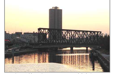
砲弾搬送のための鉄橋
