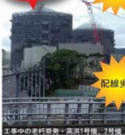
工事中の老朽原発・高浜1号機、2号機
